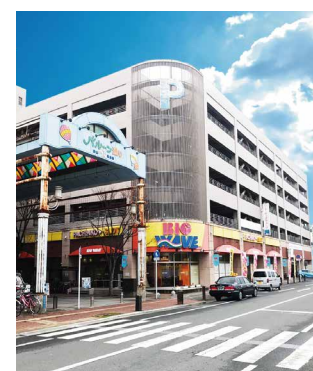
永池本店駐車場
