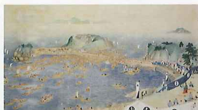
長崎 神ノ島・四郎島填海工事之図 昭和初期 長崎台場増強の一環として、佐賀藩は神ノ島と四郎島の海峡の埋立てという難工事を行った。
